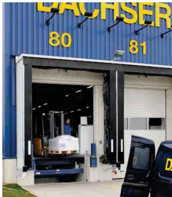
Liftleveller je kombinací nakládacího můstku s výsuvem a nůžkové zvedací plošiny.
