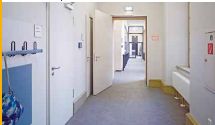
Vnitřní dveře objektu
